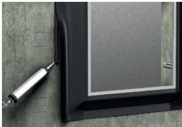
TEROSON AD KDS FR mit der Hand- oder Druckluftpistole (Luftdruck 0,5 bis 5 bar) streifenförmig auf den Untergrund auftragen.
