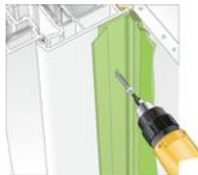
Bild2: Befestigung mit geeigneten Schrauben.
