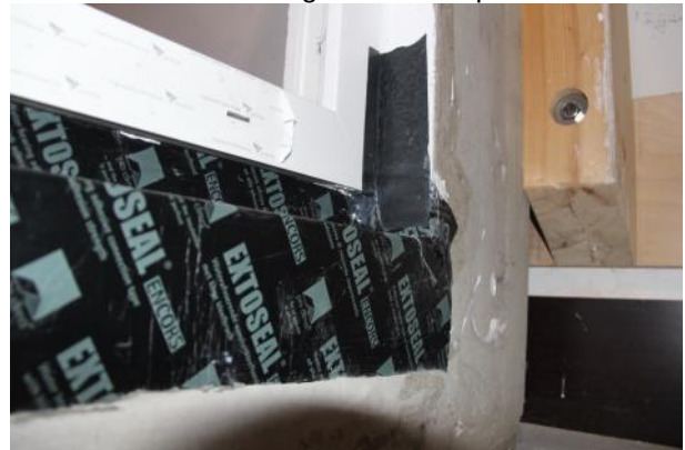
Bild 6 Anschluss, außen, unten (nicht Bestandteil der Prüfung)
