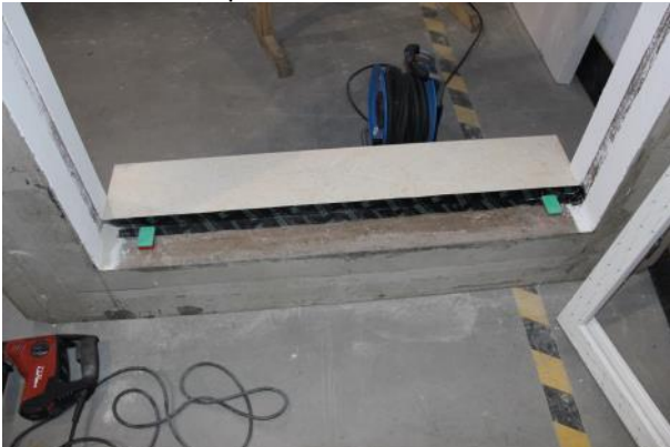
Bild 3 Vorbearbeitung des Baukörpers
