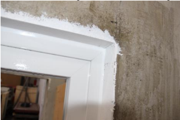
Bild 11 Prüffertiger Anschluss, außen
