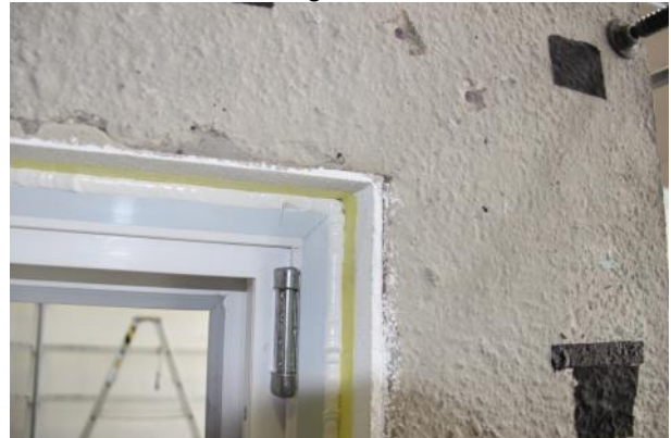
Bild 12 Dichtstoffeintrag, innen
