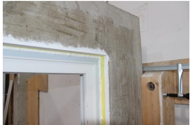
Bild 10 Dichtstoffeintrag, außen
