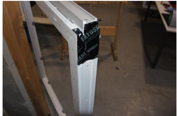
Bild 2 Vorbehandlung, Fensterbankanschlussprofil
