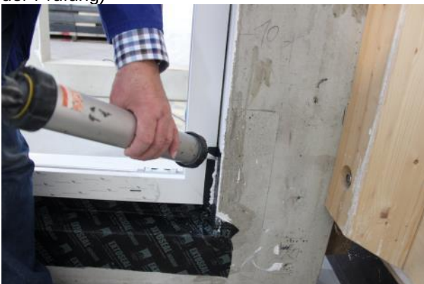
Bild 7 Vorbearbeitung, unten, vor Leistenmontage
