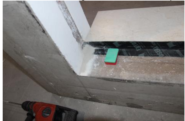
Bild 4 Vorbearbeitung des Baukörpers
